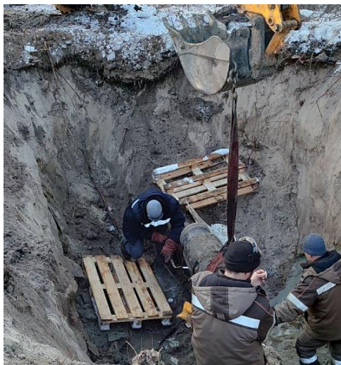
Рис. 2. Пример несоблюдения требуемой крутизны откосов и отсутствие крепления стенок котлована
