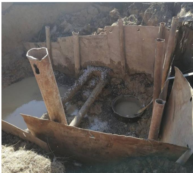
Рис. 3. Пример ограждения котлована из подручных материалов
