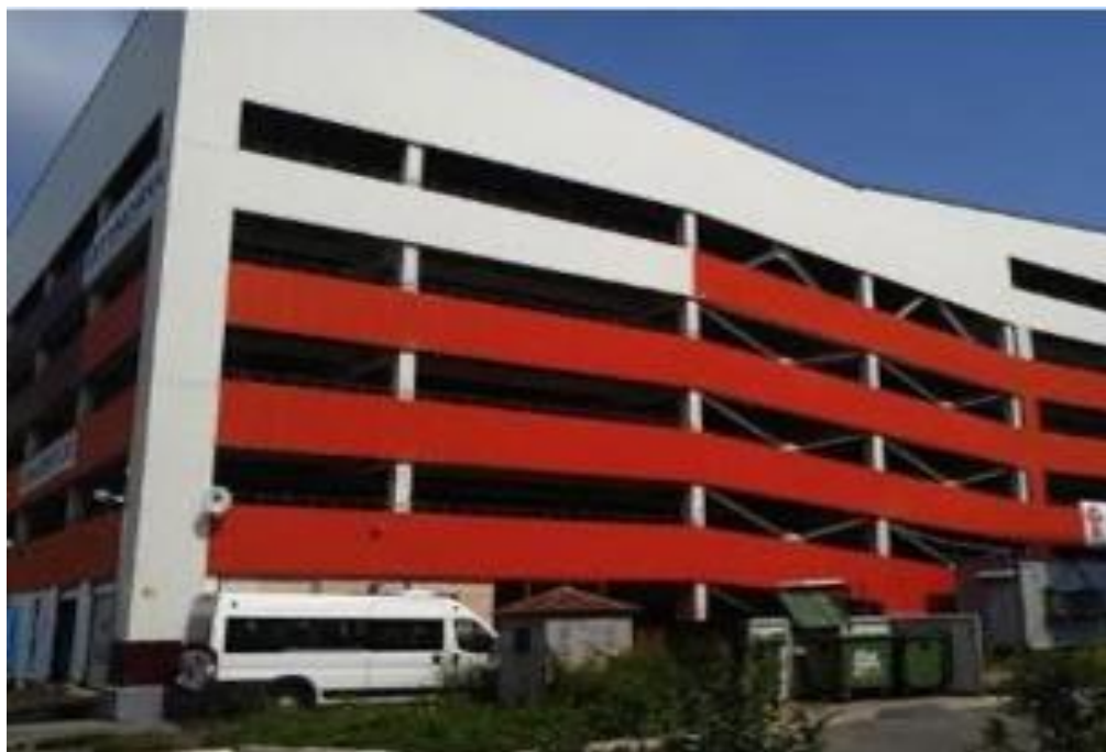
Рис. 3. Многоярусный паркинг открытого типа с ограждением в виде металлического ограждения и с ограждением в виде парапета
