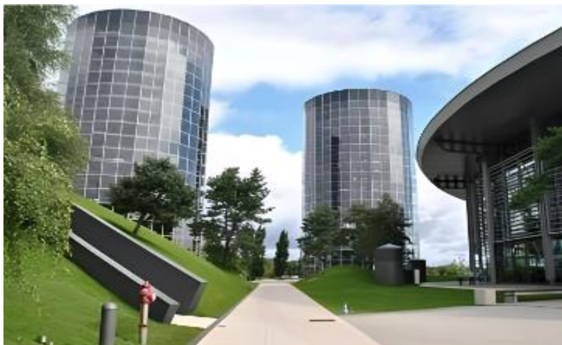
Рис. 6. Здание паркинга закрытого типа со светопрозрачными ограждающими конструкциями (16-этажная башня-паркинг в технопарке фирмы Volkswagen)
