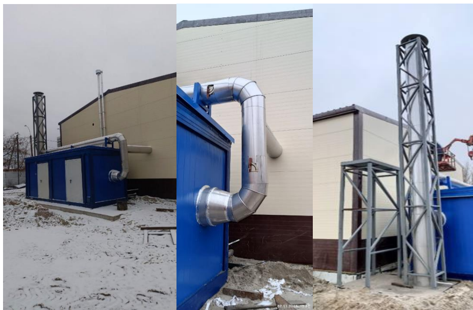
Рис. 3. Данные фотофиксации после реконструкции системы вентиляции КНС с установкой системы очистки воздуха
